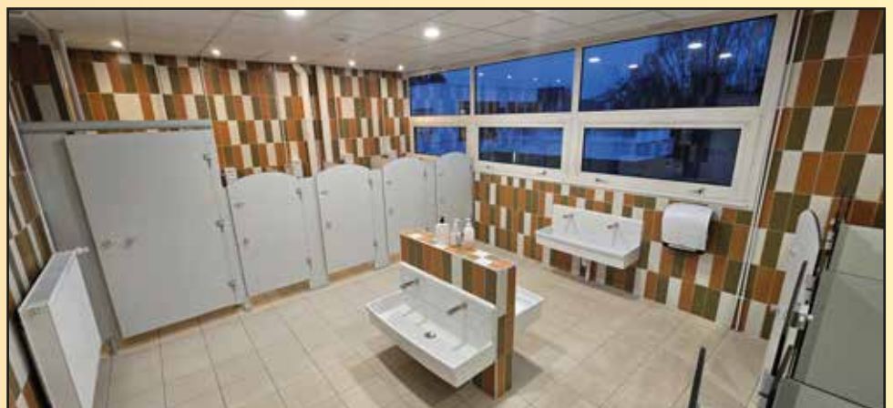
Rénovation des toilettes pour les enfants de la maternelle.
