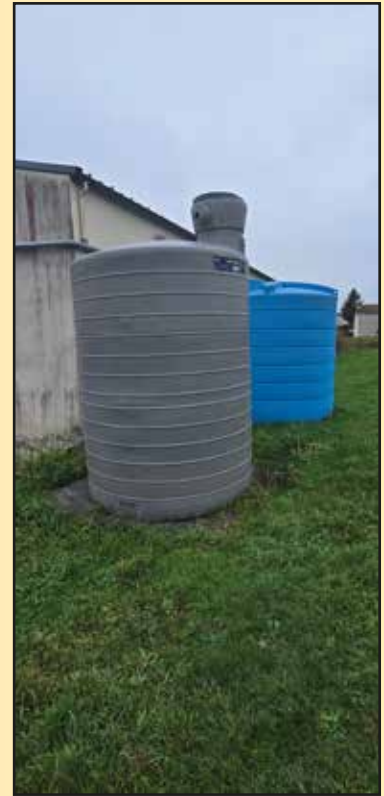
Mise en place d'une seconde citerne à eau pour les besoins du service technique.
