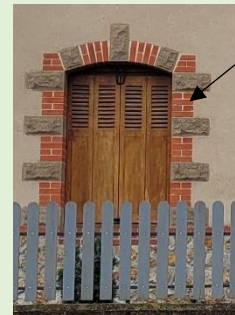
Chaînage d'angle
