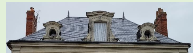
Lucarnes et éléments de toiture
