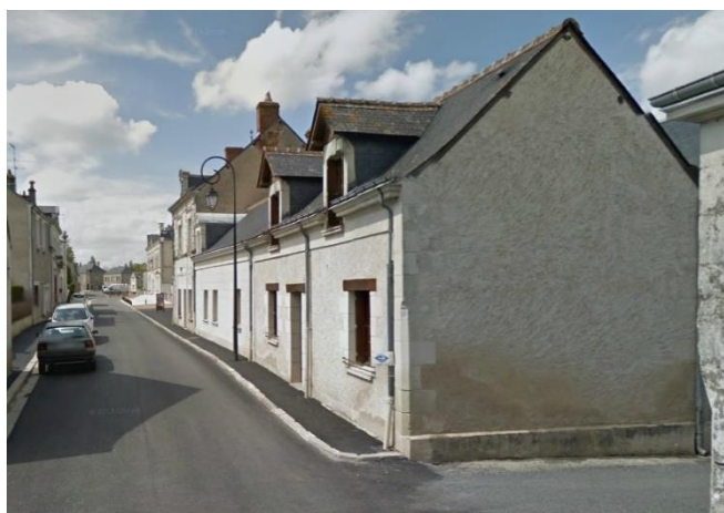
Maison de bourg à l'angle des rues du Général Chanzy et du 11 Novembre
