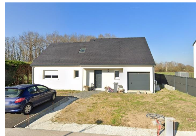
Ouverture en PVC gris anthracite, toitures pentues sans comble aménagée - construction des années 2020 (allée des bouleaux)
