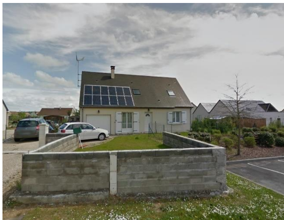
Ouverture en PVC blanc, toitures pentues pour combles aménagés - construction des années 2000 (rue des Anciens Combattants)
