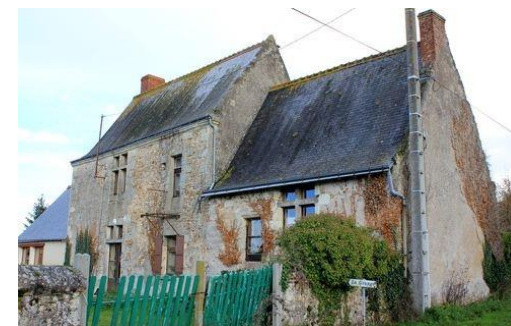
Logis de la Grange
